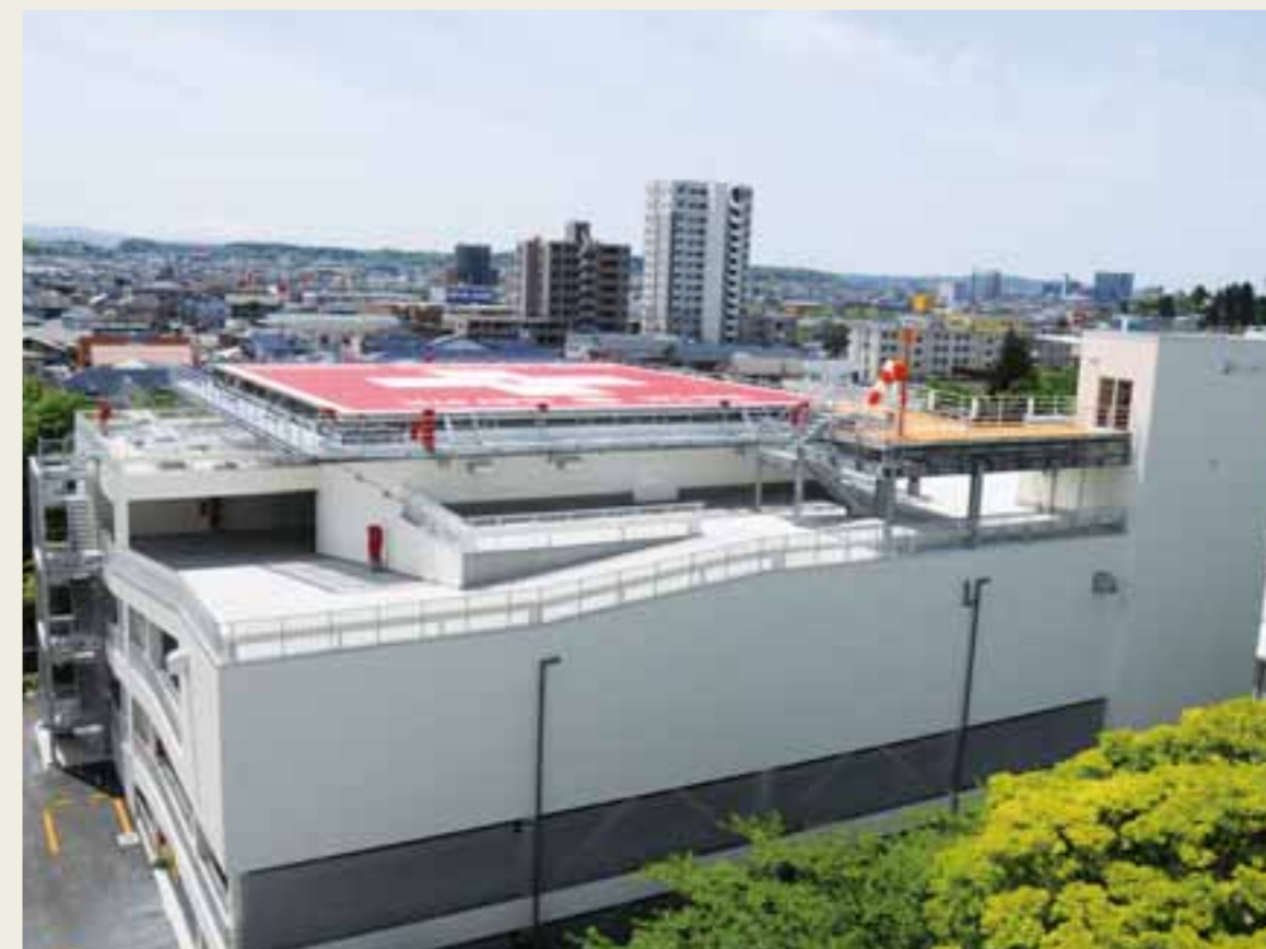
ヘリポート及び立体駐車場 helipad/parking garage
